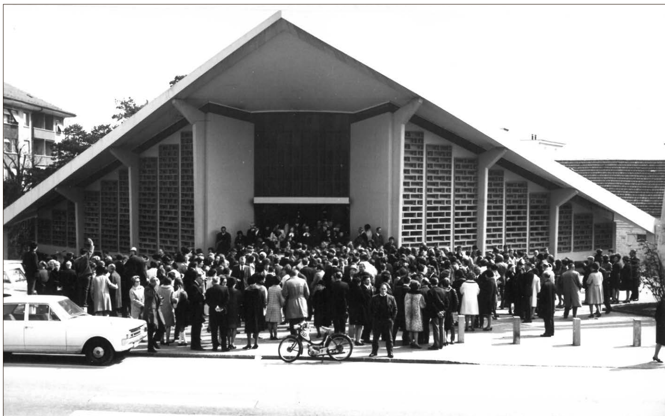
Le temple de Montbrillant fête ses 60 ans avec une célébration oecuménique ainsi qu'une exposition d'archives et de photos.
